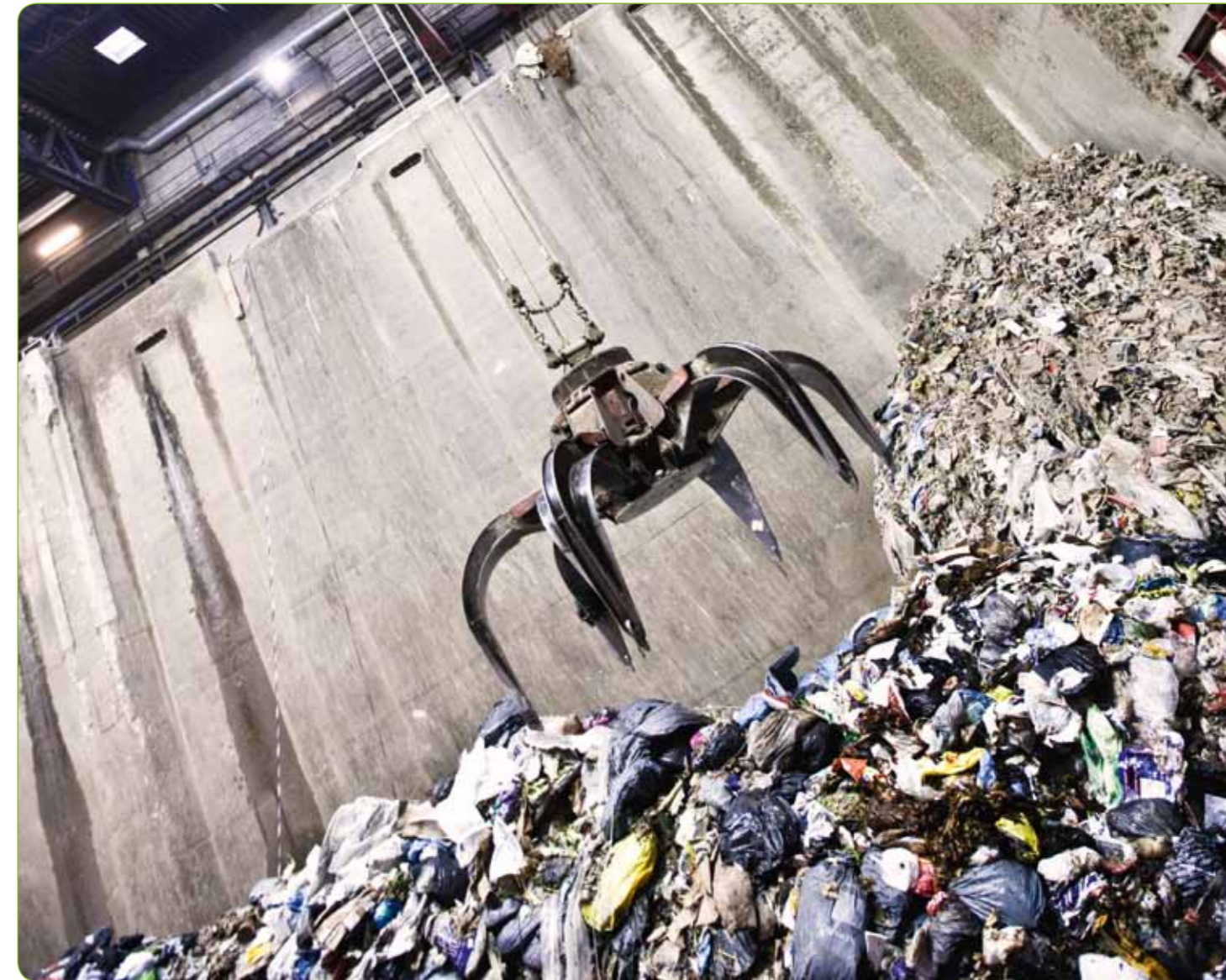
Hele 80% af fjernvarmen stammer fra overskudsvarme fra elproduktion. Affaldsforbrænding udgør 1/5 af den samlede danske fjernvarmeproduktion. Det første affaldsforbrændingsanlæg i Danmark blev opført på Frederiksberg i 1903.
