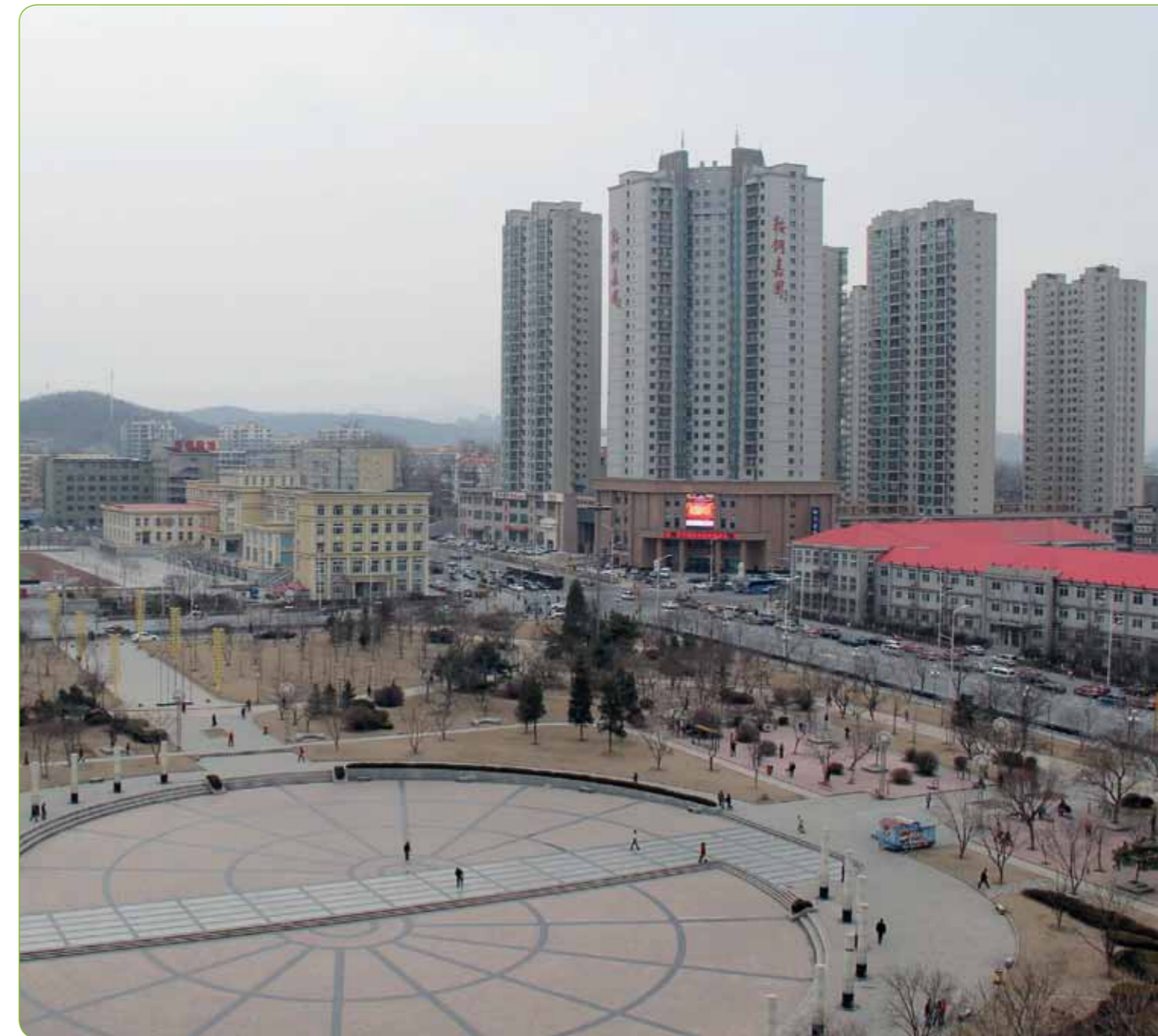
Anshan er spydspids for Kinas stålindustri, og byen huser Kinas største stålværksfabrik. Danfoss og COWI har udviklet en løsning, der genbruger varmen fra stålfabrikken og dermed har store energieffektive og miljømæssige fordele.
